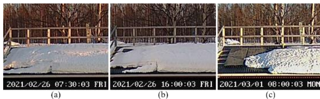
Figur 4: (a) anläggningen innan den sista eluppvärmningen, (b) efter eluppvärmning, (c) efter helgen när den mesta återstående snön smält undan naturligt från modulgruppen.
