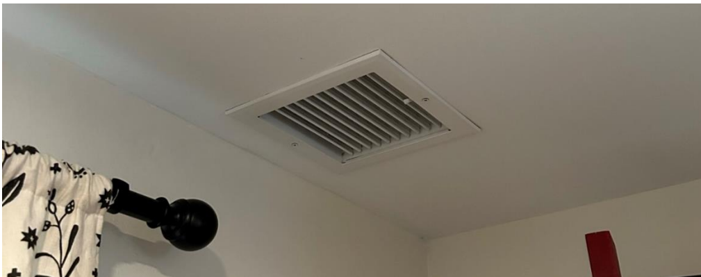
Figur 19: Tilluftsventil vardagsrum.
