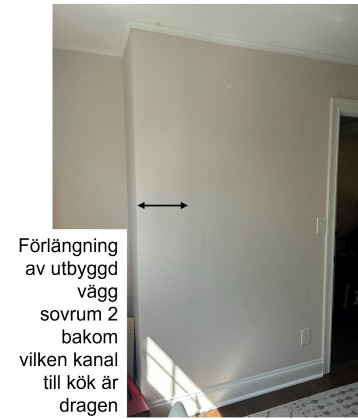
Figur 20: Den utbyggda väggen i sovrum 2 på övervåningen förlängdes med ca 20–25 cm för att gömma kanaldragning från vind via våning 2 till underliggande kök. Kanaldragningen utfördes av kontrakterad HVAC entreprenör, medan snickeriarbetet utfördes av husägaren själv i samband med renoveringen.
