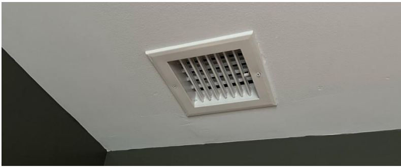
Figur 25: Tilluftsventil badrum 2, nedervåning.
