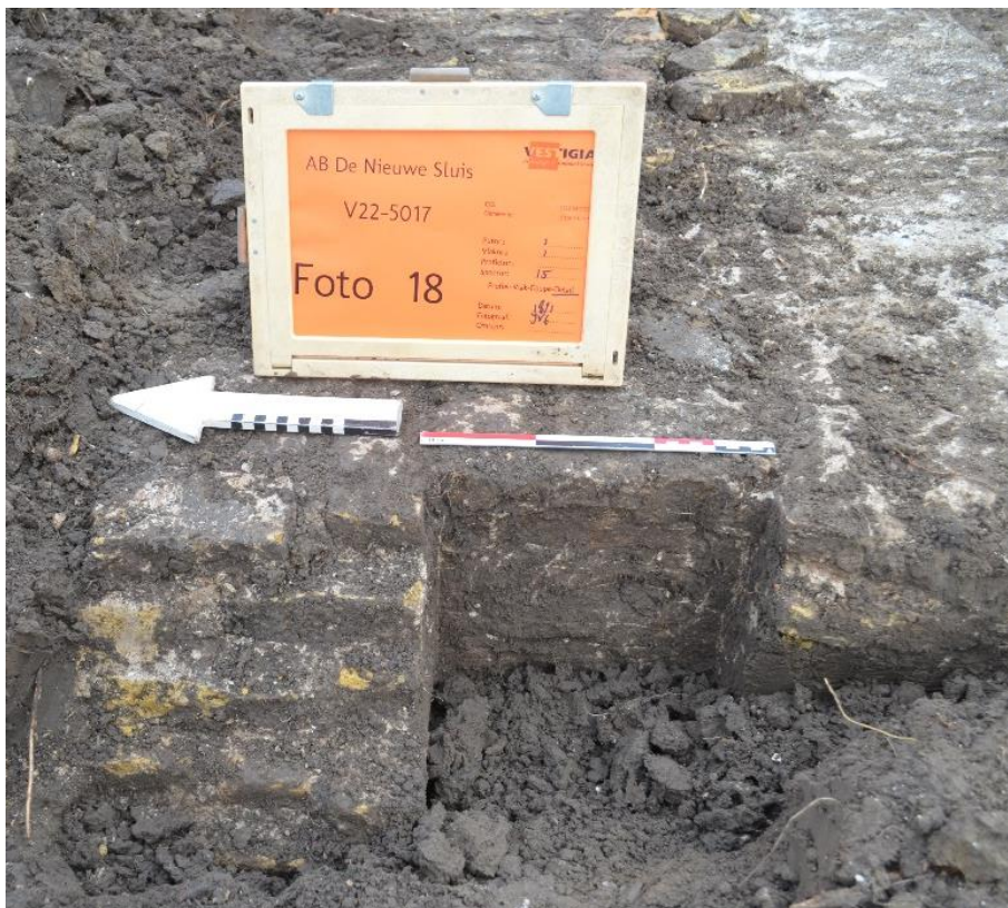
Afbeelding 15: De inkeping in de steunbeer aan de noordoostzijde van de sluis. Foto: Vestigia 2023.
