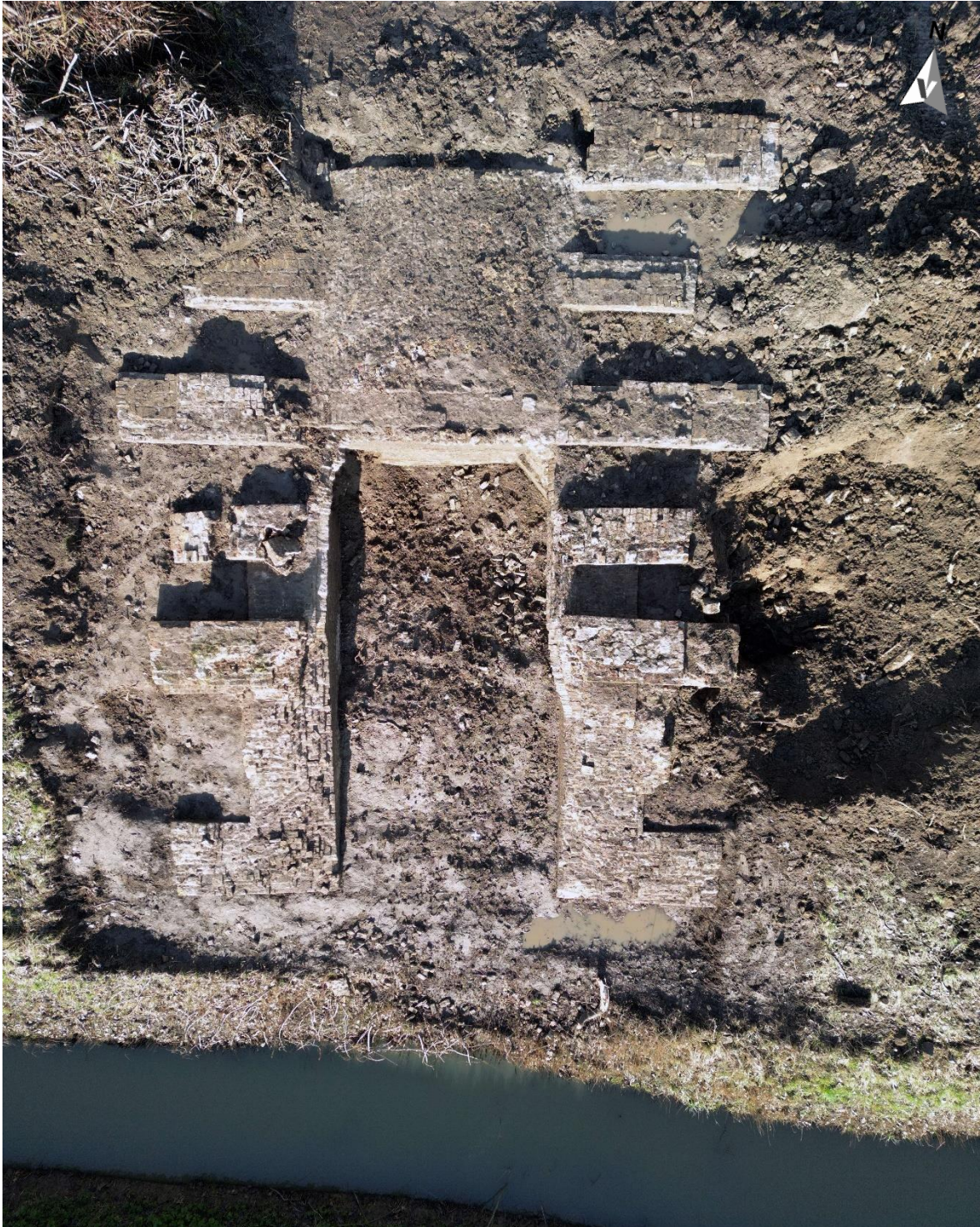
Afbeelding 9: Bovenaanzicht van de sluisconstructie. Noorden is aan bovenzijde van de foto. Foto: BVL De Winter.
