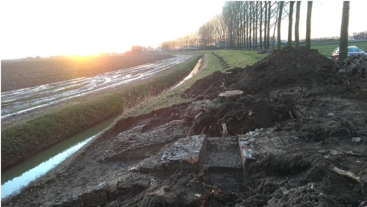
Afbeelding 17: De vrijgelegde sluisconstructie, al aanwezig vlak onder het oppervlak. Maar ook de bomen staan direct in of naast de sluisgang. Foto: Vestigia 2023.
