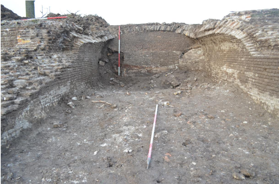
Afbeelding 13: Aanzicht in de sluisgang naar het noorden, waarbij het koepelgewelf en dwarswand duidelijk is. Foto: Vestigia.
