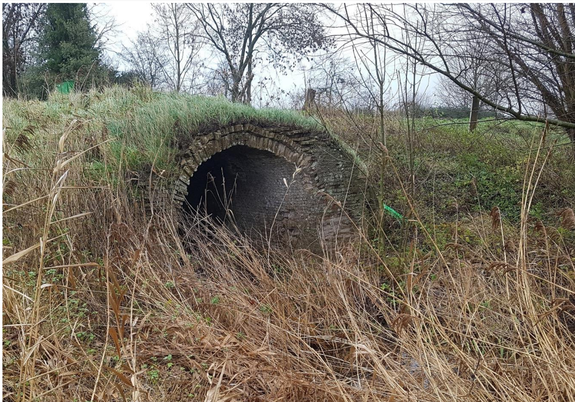
Afbeelding 14: De sluisconstructie Hoevense Wielen, een duikersluis of heul met een vergelijkbare metselwerk en gewelfconstructie. Foto: Waterschap Brabantse Delta.
