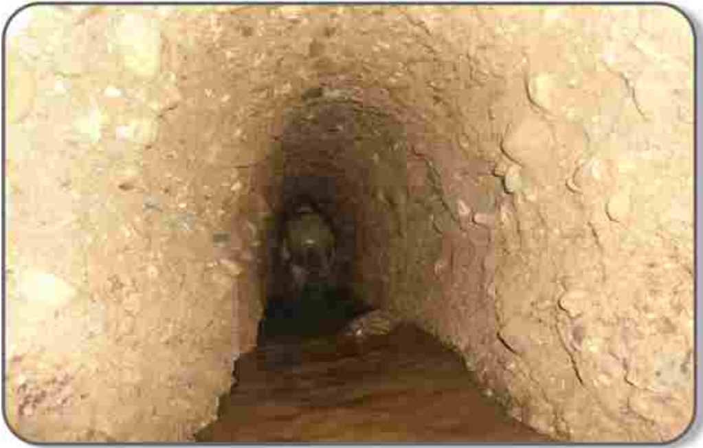
Nova sekcija tunela pod vodom
