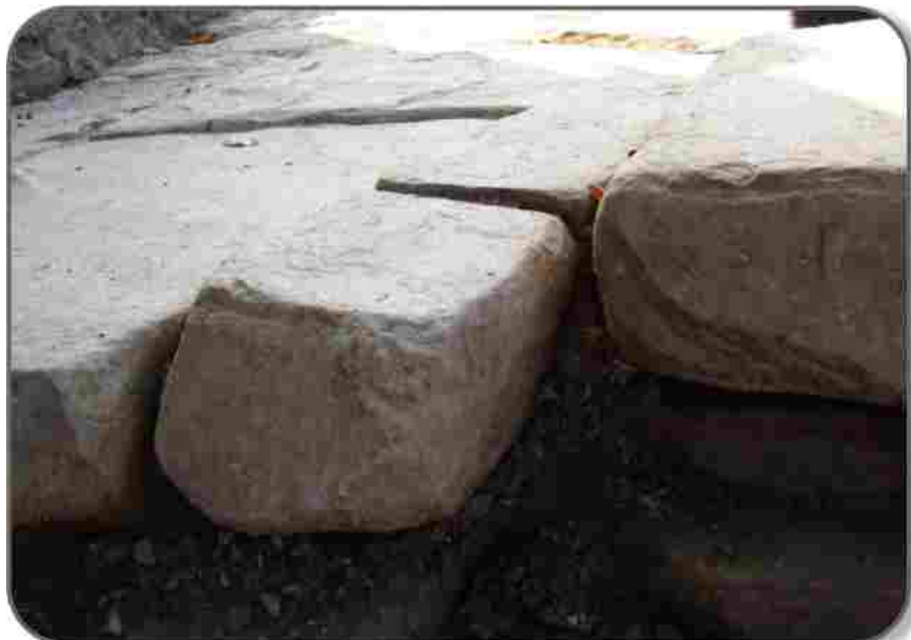
Gornji sloj ploča pješćara je lijepljen na osnovicu obrađenih ploča.
