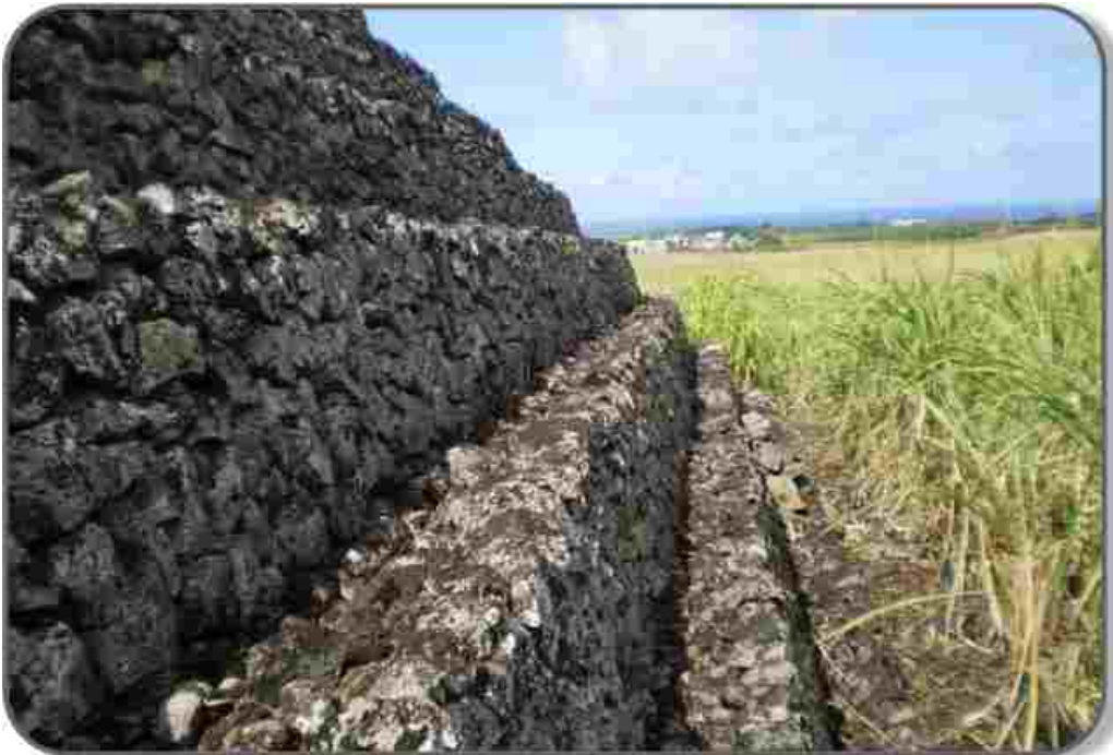
Uočljiva je kompaktnost gradnje svih sedam piramida; mada nema vezivnog materijala ipak su strukture ostale sačuvane dugi period od njihove izgradnje zahvaljujući vještini drevnih majstora.
