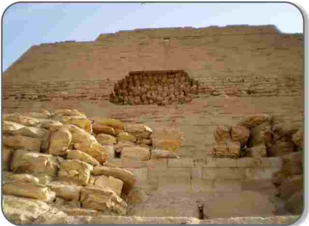
Oštećene sekcije vanjskog omotača piramide u Meidumu
