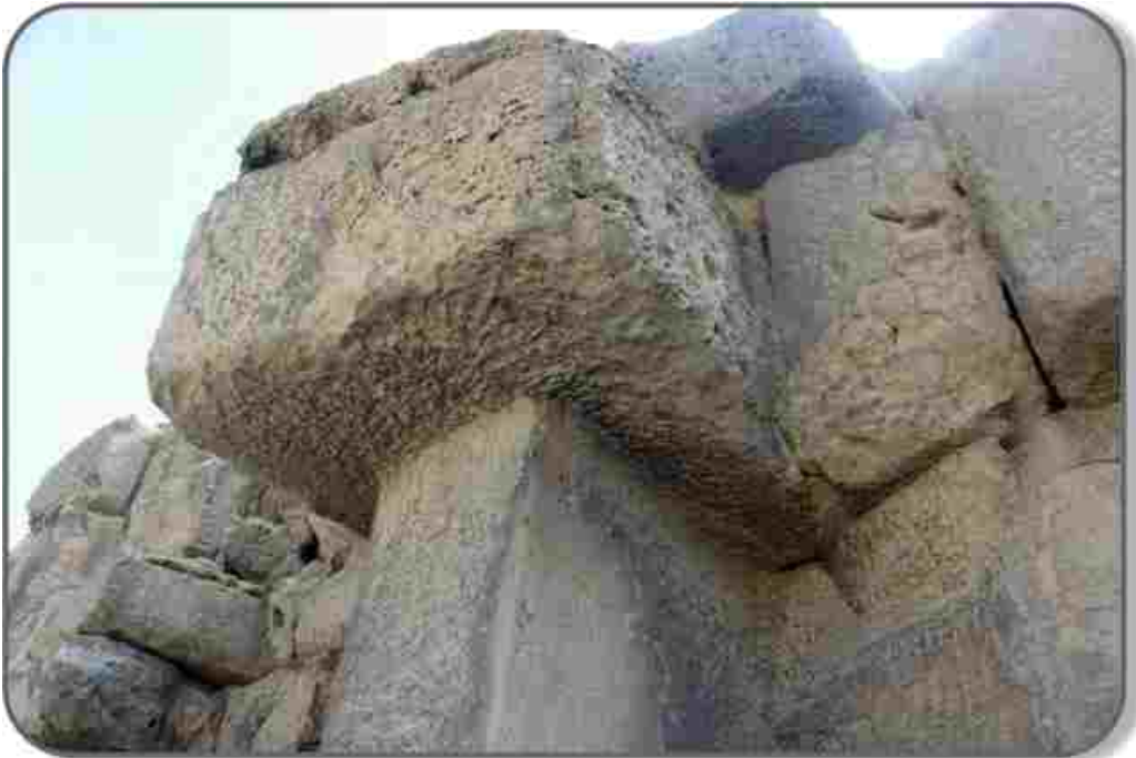
Oštećeni vanjski omotač Keopsove piramide otkriva da je još uvijek prisutna dilema kako su blokovi ugrađivani u ovu strukturu: (1) Oblikovani u tri obližnja kamenoloma, (2) Lijevani na licu mjesta što im daje „stopljeni” izgled, ili (3) Kombinacijom ove dvije tehnike gradnje
