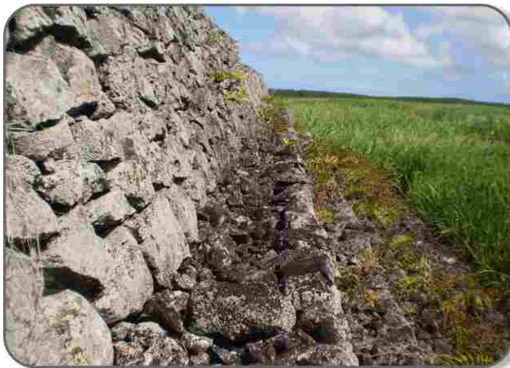
Unutrašnji nagib doprinosi stabilnosti građevine
