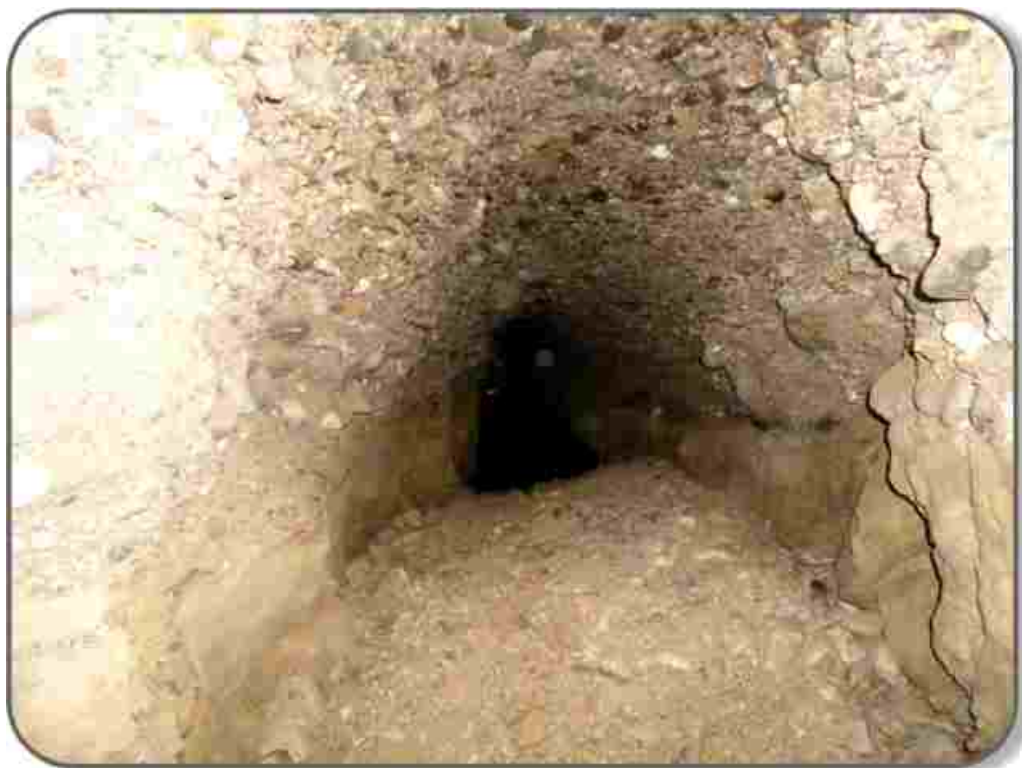
Podzemni tuneli su napravljeni u konglomeratu.
