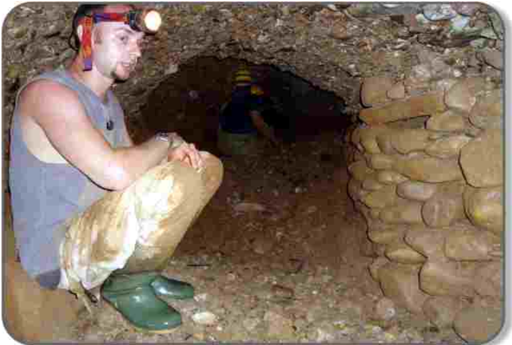
Suhozid u novim sekcijama tunela
