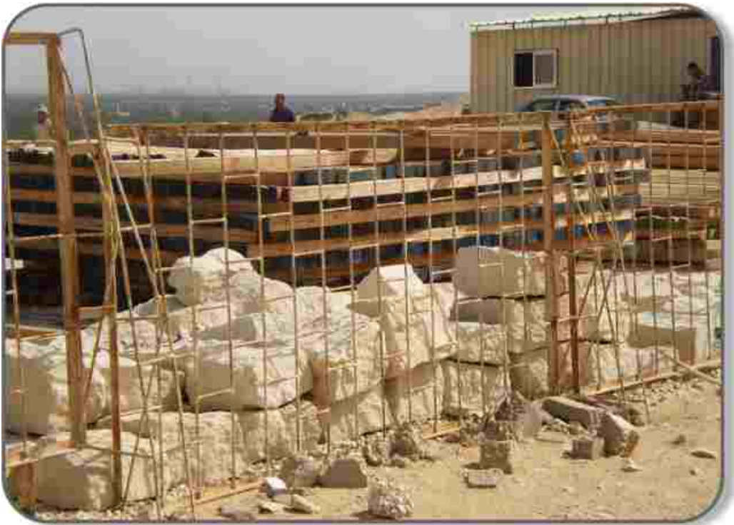
Kameni blokovi spremni za ugradnju u Stepenastu piramidu
